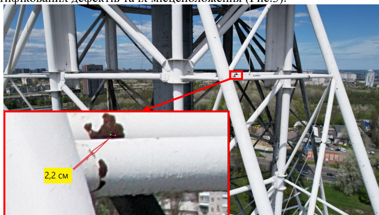
Рисунок 3 – Вимірювання розміру дефекту з допомогою програмного забезпечення 3DF Zephyr
